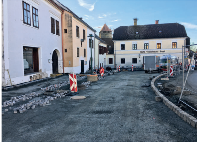
Abb. 2a: Hauptplatz Richtung Süden, Stadtschlaining, 2021
